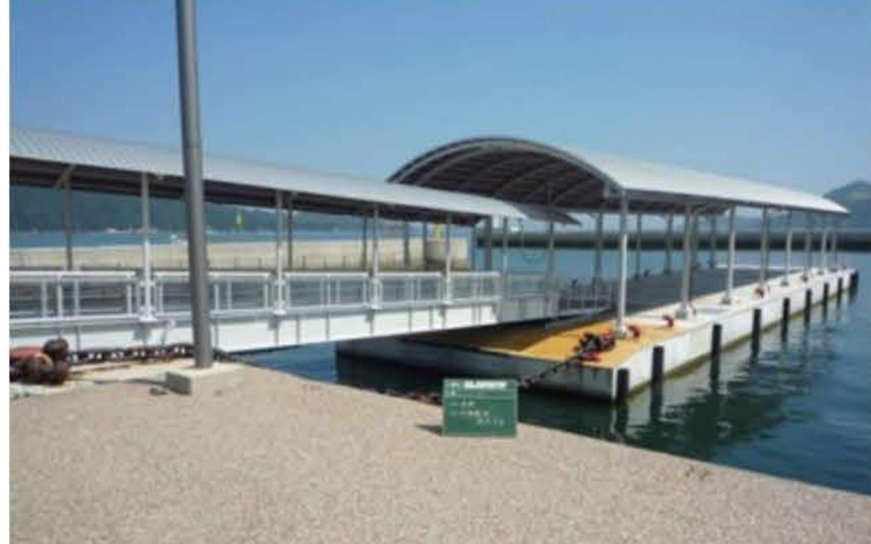
鳥羽港 浮き桟橋
