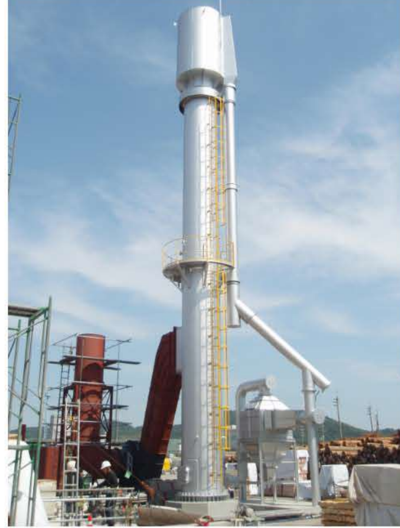
ボイラー棟新設工事
