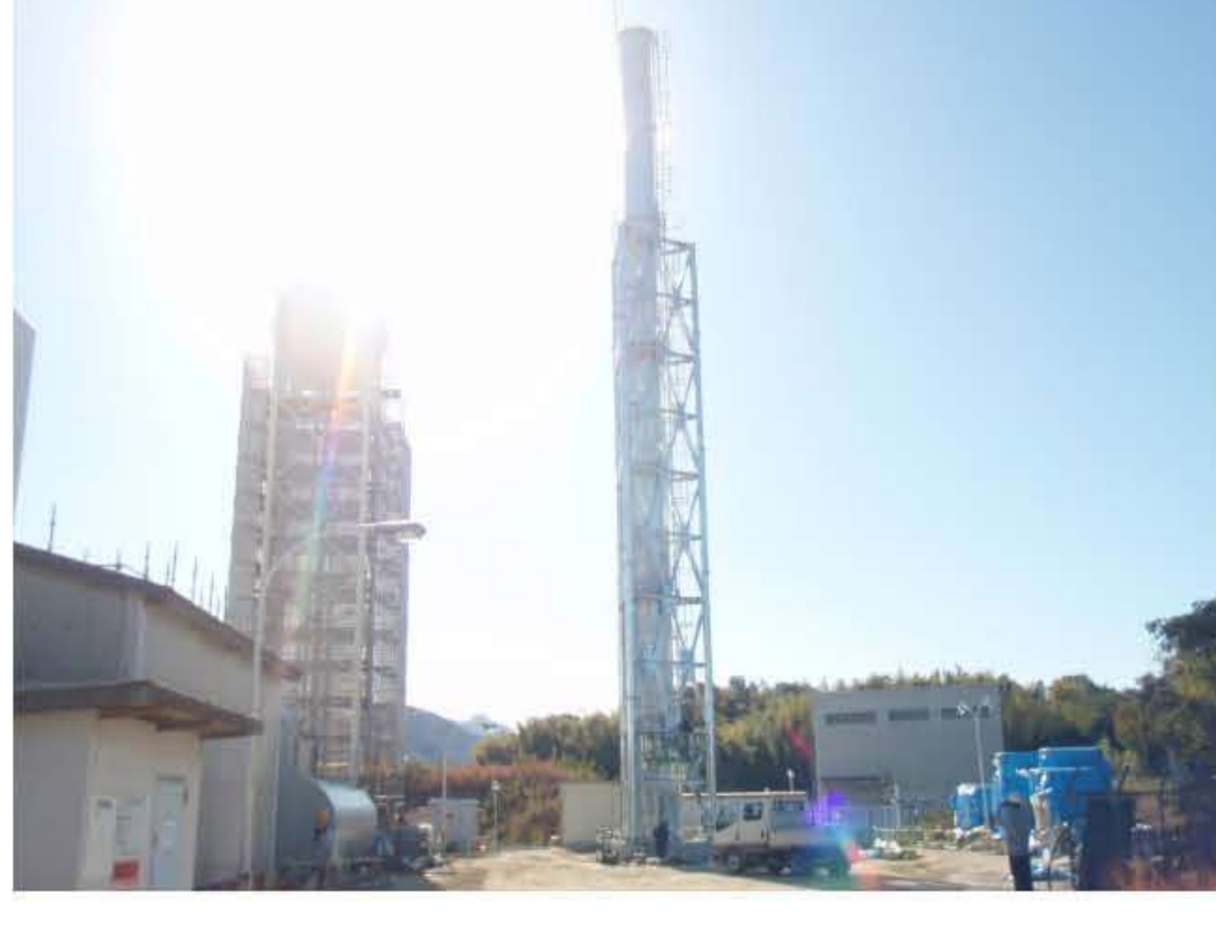
煙突製作工事
