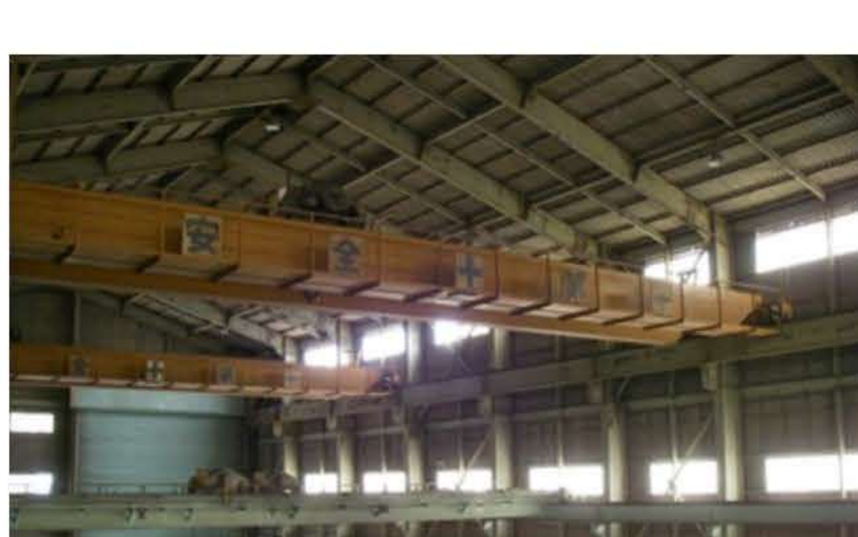
大型クレーン
